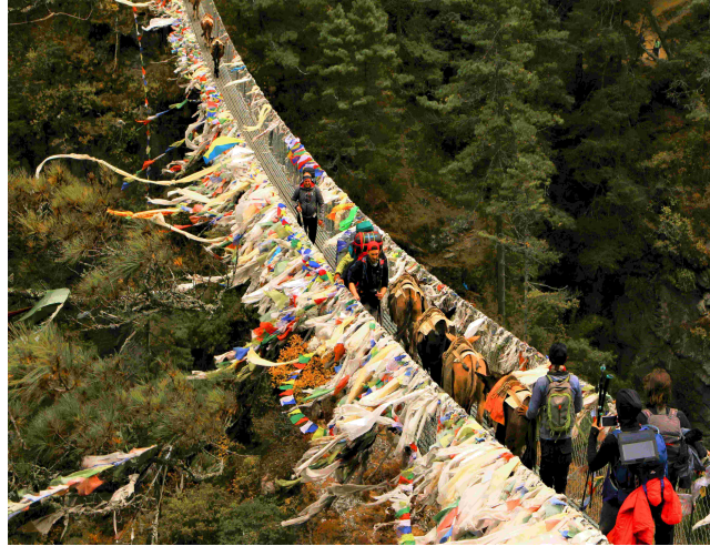
Hängebrücke im Kumbugebiet vor Namche Batar
